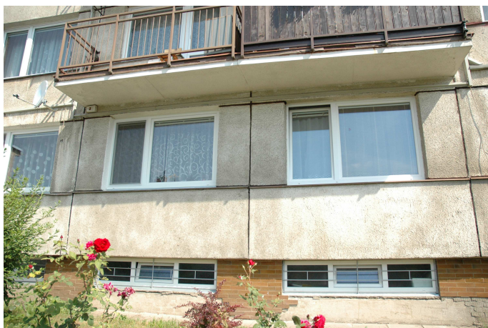
Obr. 04: Jižní průčelí – nová okna 1.PP, nové mříže oken, zbytky kabřincového obkladu.
