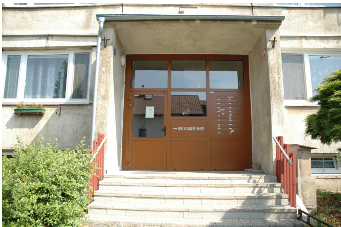
Obr. 03: Jižní průčelí – balkonové desky se zábradlím – styk dvou sekcí, modul 3,6 m.
