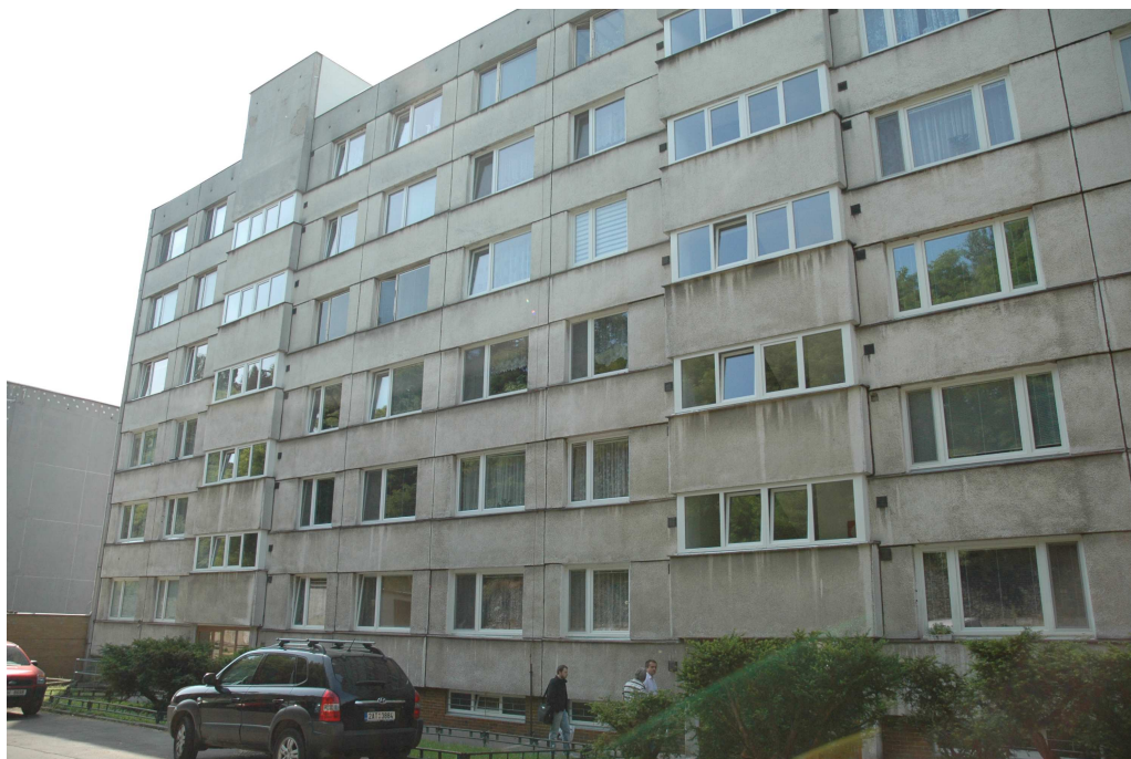
Obr. 05: Vstupní severní průčelí domu. Vstup na podestu schodiště. Předsazený modul schodiště.
